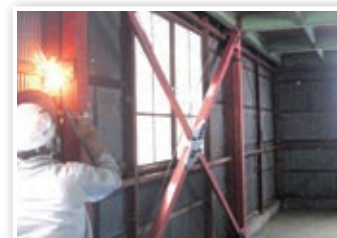
▲既存倉庫棟・耐震補強工事
