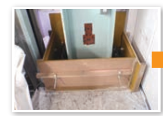
▲柱脚根巻き補強▲
