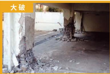
柱のせん断ひび割れ、曲げひび割れによって、鉄筋が座屈し、耐力壁に大きなせん断ひび割れが生じて、耐力壁に著しい低下が認められるもの。
