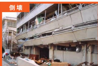
柱・耐力壁が大破壊し、建物全体または建物の一部が崩壊に至ったもの。
