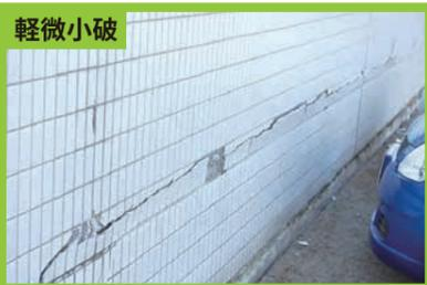
柱・耐力壁の損傷は軽微であるが、RC二次壁等にせん断ひび割れが見られるもの。
