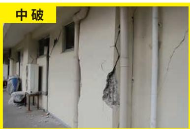
柱に典型的なせん断ひび割れ・曲げひび割れ、耐力壁にひび割れが見られ、RC二次壁・非構造体に大きな損傷が見られるもの。
