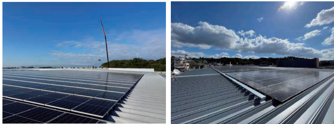
荷揚げ、パネル設置、ケーブルラック設置
