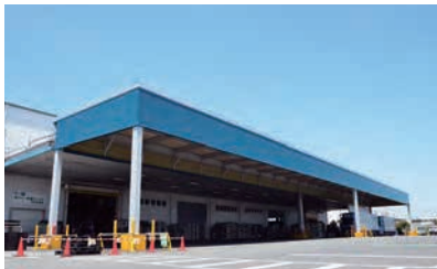
2. 強度に優れた6本の柱を設置し、トラックが出入りしやすい荷捌きスペースに
