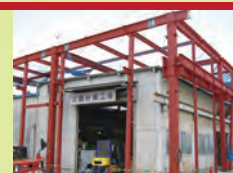
2. 強度に優れた6本の柱を設置し、トラックが出入りしやすい荷捌きスペースに
