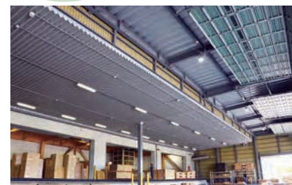
1. 既存の庇を新設した屋根の一部に取り組みことで強度を確保
