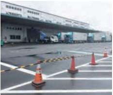
既存の荷捌き場は庇があるものの、資材が風雨にさらされることもあった
