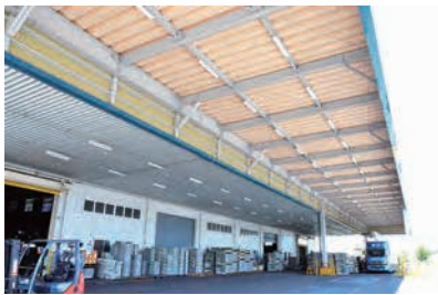
1. 荷捌きスペースの底部分を約2倍に拡張
