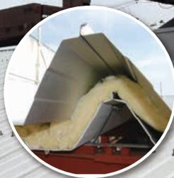
既存屋根に覆いかぶせるように、新規屋根(折板)を重ね、その間に断熱材(グラスウール)を敷き込みます。断熱性・遮熱性が改善されることで空調コストを軽減でき、快適な作業環境を実現します。
