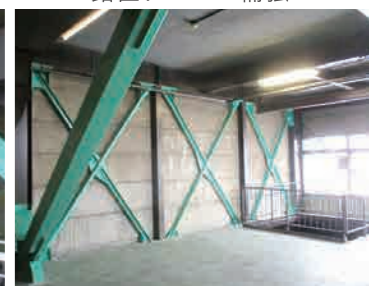
鉛直ブレース補強
