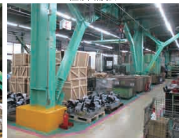
鉛直ブレース補強
