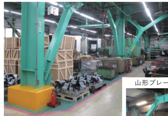
東日本大震災を受け南海トラフ地震がいつおきてもおかしくない中、事業継承に備え耐震補強工事のご依頼を頂きました。工場の稼働を止めずに耐震補強のご要望にお客様の生産性、作業動線を考慮し土日と連休でできる補強案をご提案しました。工場の補強は、山形ブレース補強とマンサード形ブレース補強を採用。極力工場の製造ラインに影響がない計画にし、足元に柱脚補強を行い補強部材が有効に働くようにしました。倉庫の補強は、補強効率の良い鉛直ブレース補強を採用し経済的な計画にしました。
