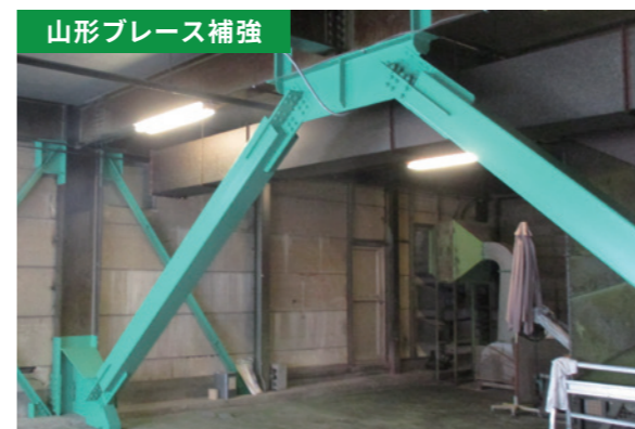
1,2階の工場の補強は山形ブレース補強及びマンサード形ブレース補強を採用することにより、極力工場の製造ラインに影響がない補強を計画しました。
