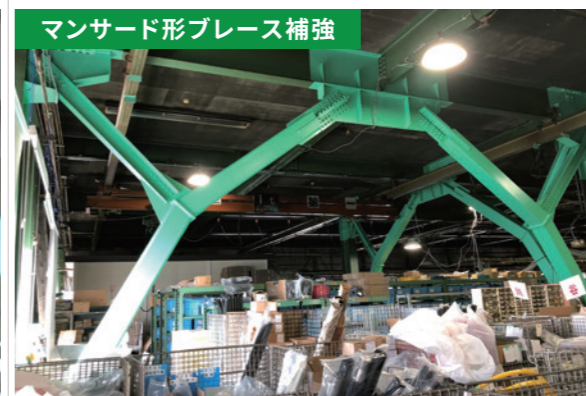
1,2階の工場の補強は山形ブレース補強及びマンサード形ブレース補強を採用することにより、極力工場の製造ラインに影響がない補強を計画しました。
