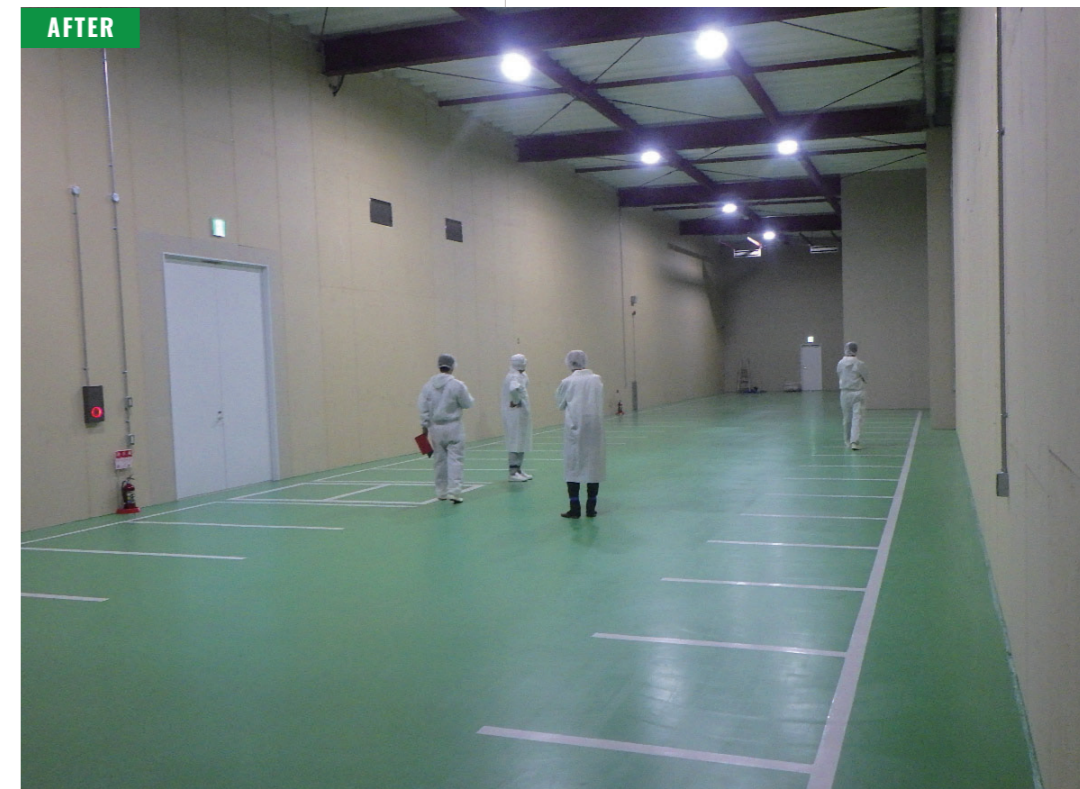
2階床の増床 完成
