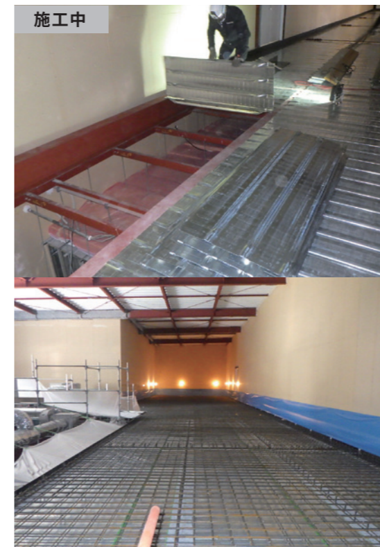
2階床の増床 施工中
